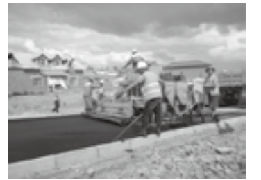
AS舗装工事の現場▶P.25
