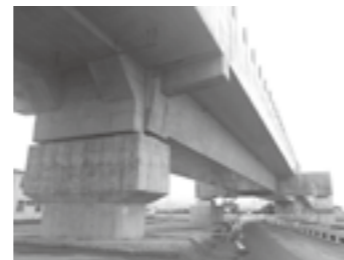
馬桁一体型2径間連続PC箱桁完了写真▶P.15
