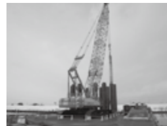
フライングハンマー工法(150tクレーン)▶P.21
