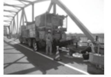
コンクリート打設状況(モービル車使用)▶P.29
